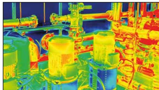
Beim kombinierten Bild kann der Anteil beider Teile prozentual eingestellt werden.
